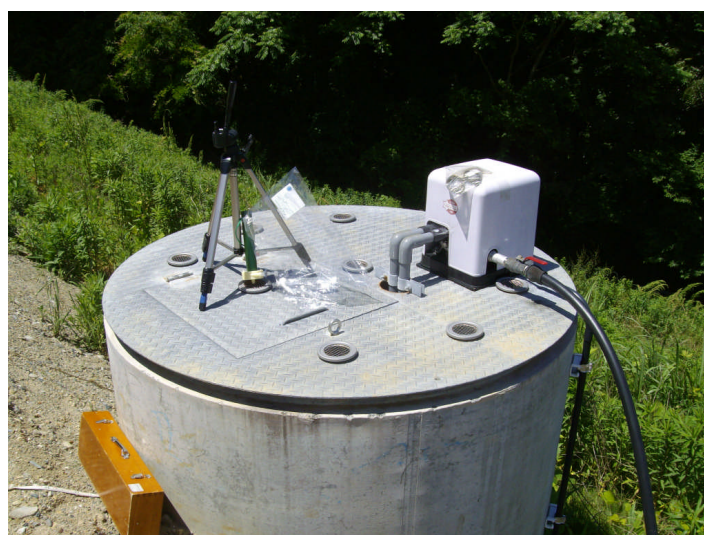
写真4-4-1 ガス抜き管及び調査地点No.4の調査状況
